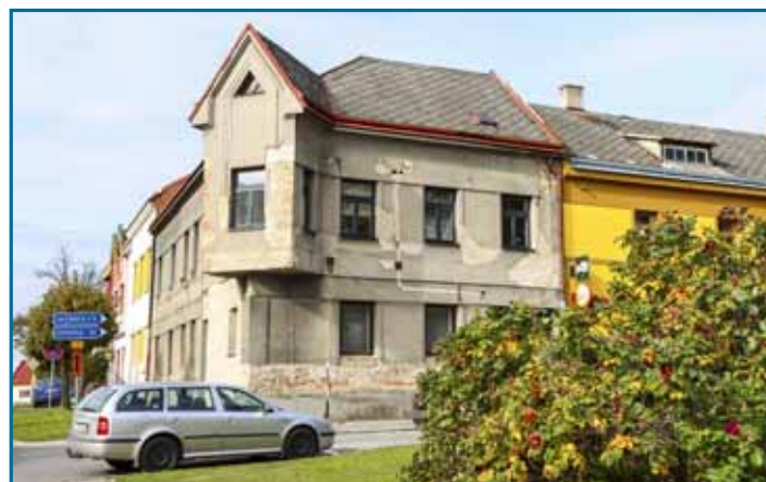
▲ Dům na Bechyňově náměstí, v němž četnická stanice sídlila. Všechny exekuce partyzáni provedli ve sklepech.
