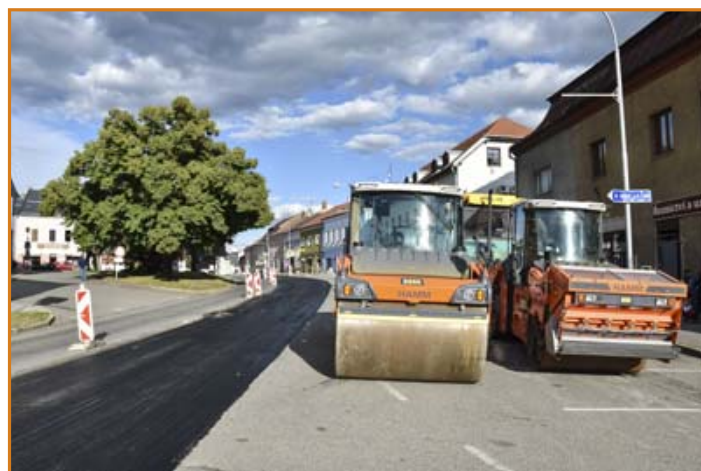
▲ Rekonstrukce silnice I/19 v Přibyslavi. Foto: Michael Omes
